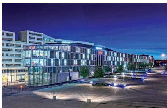
La Halle de Metz, siège régional de la Caisse d'Epargne (Architecte : ANMA)
